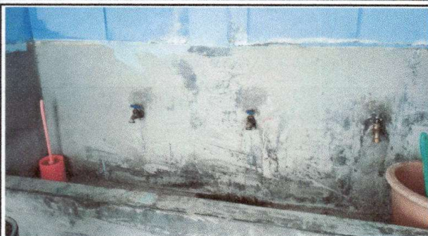
Foto1: sustitucion llave de chorro
