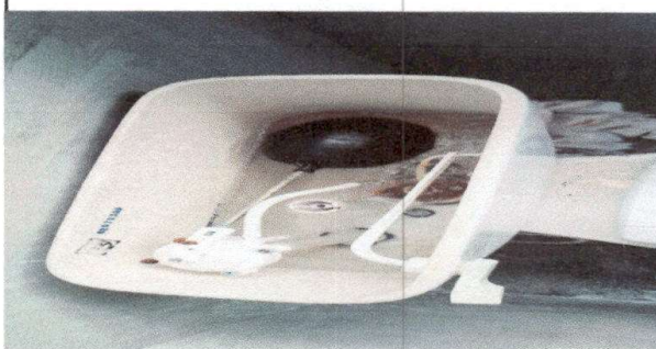
Foto 4. Sustitucion accesorios de inodoros
