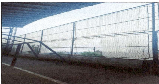
Foto 5: Reparacion de tubo hg malla galvanizada
