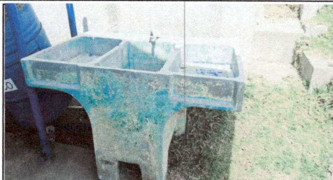
Foto 2: sustitucion pila de cemento de dos lavaderos
