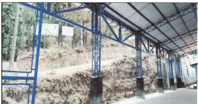
Foto 3: Sustitucion de canal de pvc
